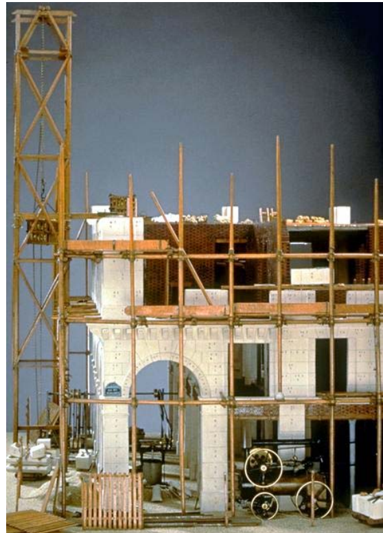
8 Immeuble en construction rue de Rivoli, 1878. Inv. 9504
