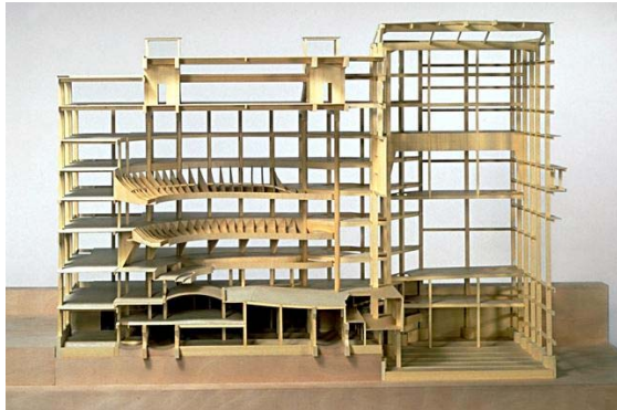
9 Ossature en béton armé, Théâtre des Champs-Élysées, 1913. Inv. 43968
