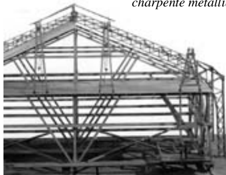
Échafaudage pour charpente métallique
