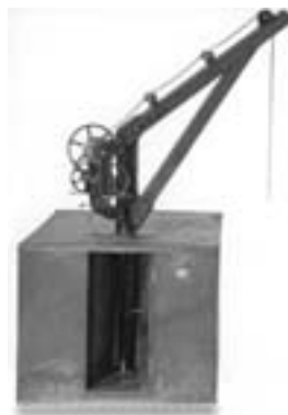
Grue de Cavé
