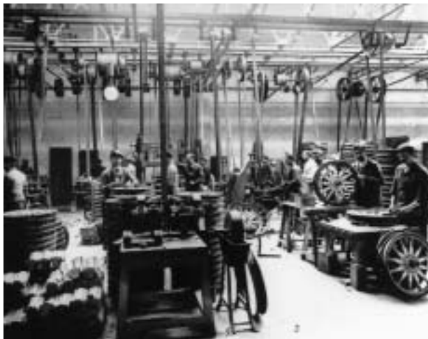
Distribution de l'énergie dans un atelier, courroies et poulies
