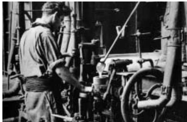
Fabrication mécanique d'une bouteille avec une machine Boucher à la verrerie Lecocq à Arleux dans les années 1930
